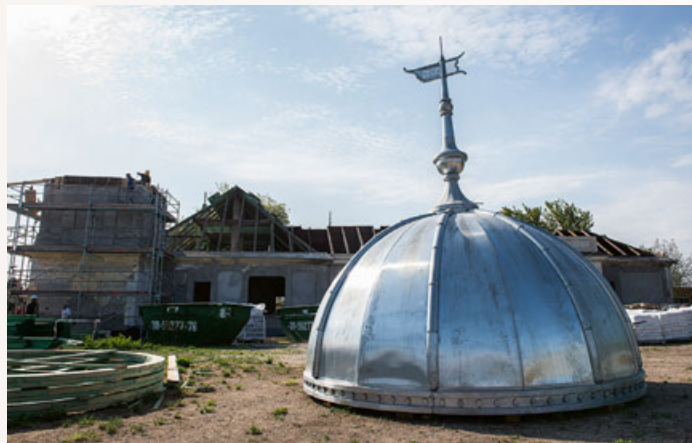
Elkészült a kupola bádogozása, 2015. április 24. – Fotó: Csákvári Zsigmond
